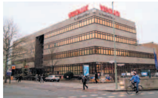
Auf dem Bechsteinhaus prangt noch der Visolux-Schriftzug. Seit 2007 steht das Gebäude leer
