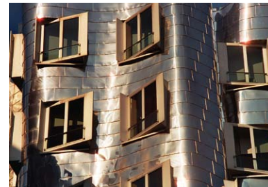
„Neuer Zollhof“ im Düsseldorfer Medienhafen, Edelstahlfassade, Architekt: Frank O. Gehry
